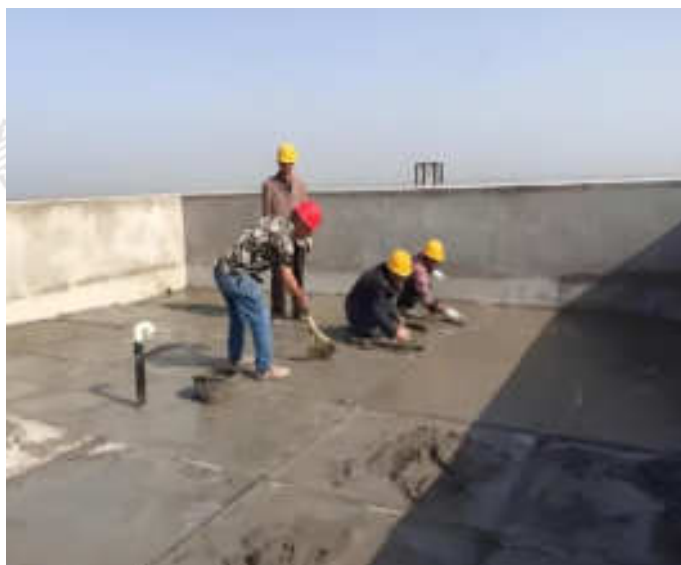
单元式分区施工照片
