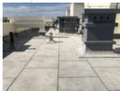
通风口、泛水处施工成品照片
